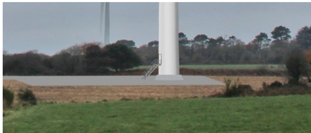
Pied de mât avec une surélévation
