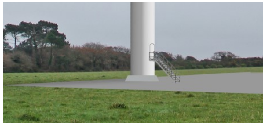
Pied de mât avec une surélévation
